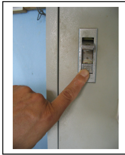
รูปที่ 15 ปุ่มเปิดประตูตู้ควบคุมเครื่องสูบน้ำดิบ
