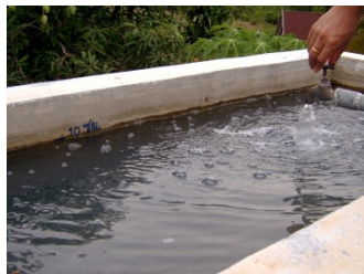
3) เติมน้ำให้ระดับน้ำ อยู่ต่ำกว่าขอบถังเตรียมสารส้ม. ประมาณ 10 ซม.
