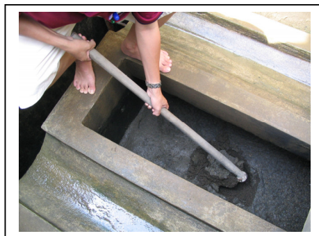
รูปที่ 64 การใช้จอบคุ้ยหน้าทรายกรอง
