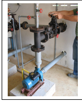
รูปที่ 48 ปิดประตูน้ำด้านท่อจ่ายน้ำของเครื่องสูบน้ำดิบ
