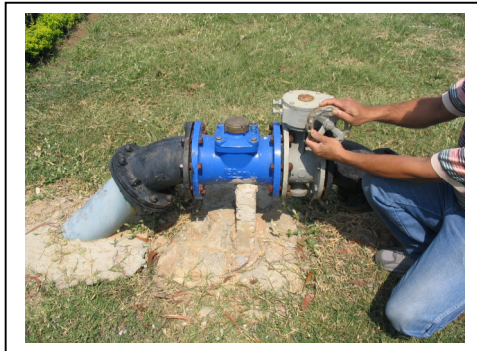
รูปที่ 60 ปิดประตูน้ำจ่ายน้ำประปา (ประตูน้ำหมายเลข 1)
