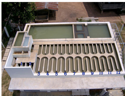
รูปที่ 54 ตำแหน่งการเกิดตะกอนรวมที่ ช่อง 5 – 6 (อัตราการผลิต 10 และ 20 ลบ.ม./ชม.)
