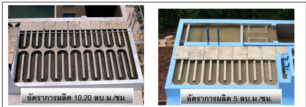
รูปที่ 29 ระบบรวมตะกอน
