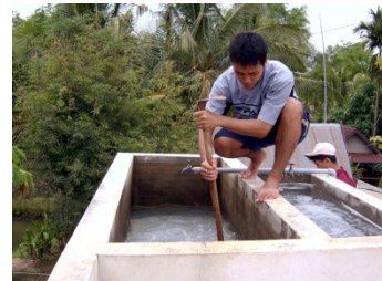
2) เติมน้ำลงไป \frac{1}{4} ของถังเตรียมสารส้ม กวนให้สารส้มละลาย
