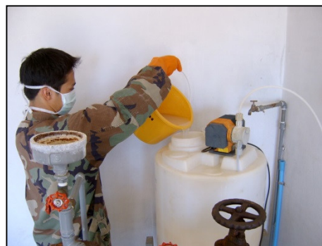
รูปที่ 45 การเติมสารละลายคลอรีนลงในถังจ่ายสารละลายคลอรีน
