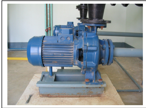
รูปที่ 6 เครื่องสูบน้ำแบบหอยโข่ง
