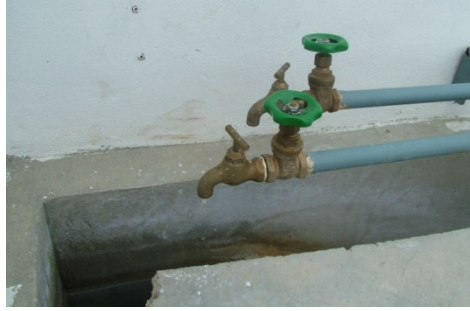
รูปที่ 28 ระบบสร้างตะกอน (ไฮดรอลิคจัม)
