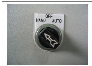
รูปที่ 50 ปิดสวิตช์ลูกศรไปที่ตำแหน่ง “HAND” หรือ “AUTO”
