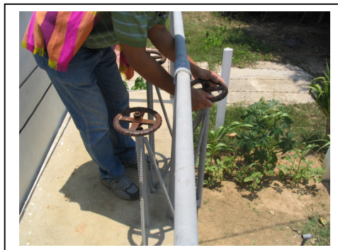
รูปที่ 56 เปิดประตูน้ำจากถังกรองลงถึงน้ำใส (ประตูน้ำหมายเลข 3)
