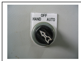
รูปที่ 19 สวิตช์ลูกศรที่ตำแหน่ง “HAND”
