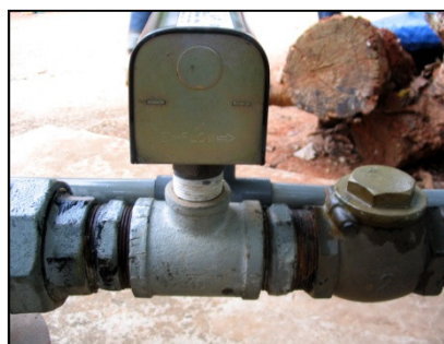
รูปที่ 25 การติดตั้งสวิตช์ใบพาย ที่ด้านบนของระบบรับน้ำดิบ
