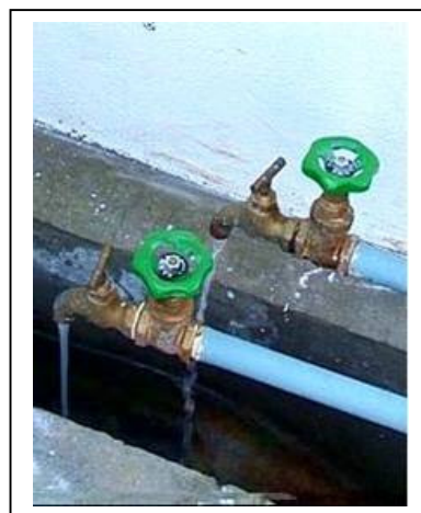
รูปที่ 52 เปิดก๊อกจ่ายสารละลายสารส้ม/ปูนขาว
