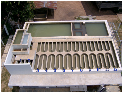
รูปที่ 68 ตำแหน่งการเกิดตะกอนรวมที่ ช่อง 5 – 6 (อัตราการผลิต 10 และ 20 ลบ.ม./ชม.)
