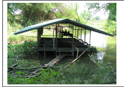
รูปที่ 3 เครื่องสูบน้ำดิบติดตั้งในโรงสูบน้ำ รูปที่ 4 เครื่องสูบน้ำดิบติดตั้งอยู่บนแพลอย
