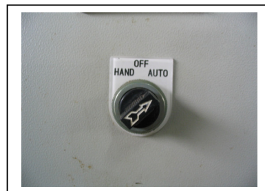
รูปที่ 50 ปิดสวิตช์ลูกศรไปที่ตำแหน่ง “HAND” หรือ “AUTO”
